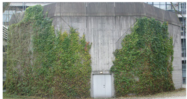
Bild 2: Klassische Fassadenbegrünung auf dem Campus Vaihingen als Gerüstbegrünung mit Kletterhilfe aus Drahtseilen.
